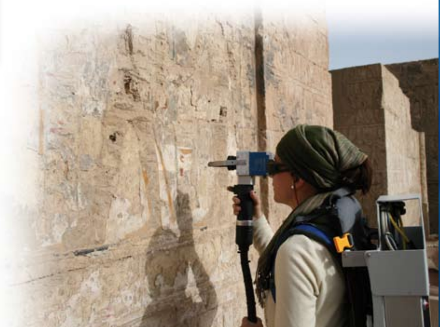
Theben: Reinigung einer altägyptischen Grabkammer des Neferhotep mit dem Backpacklaser
