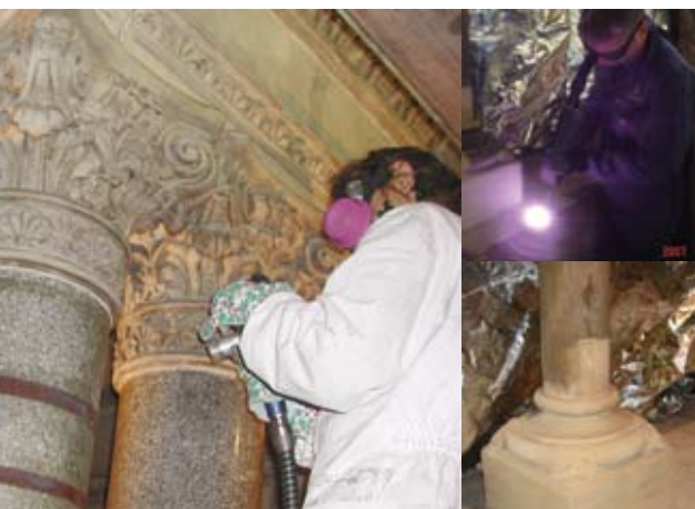
Oxford Museum: großflächige Sandsteinreinigung
