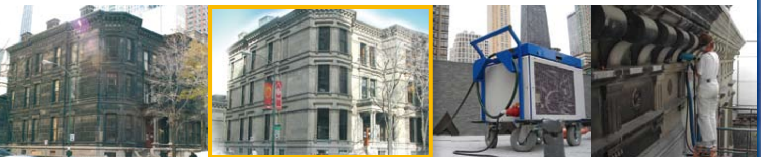
Chicago-City: Restaurierung einer Sandsteinvilla aus dem Jahr 1883, weltweit größtes laserstrahlbasiertes Restaurierungsprojekt, ca. 2500 m 2 Fläche
